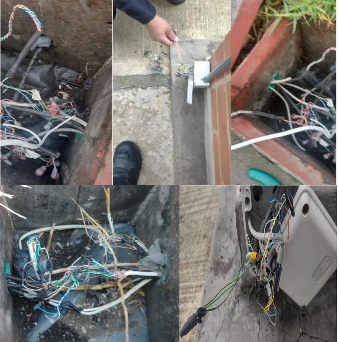
Se encuentra el cableado de 03 cámaras con empalmes abiertos se corrigen, se reinstalan en los postes, el maltrato del cableado es ocasionado por la implementación de cajas de paso inadecuado. Se deja registro de la actividad realizada.
